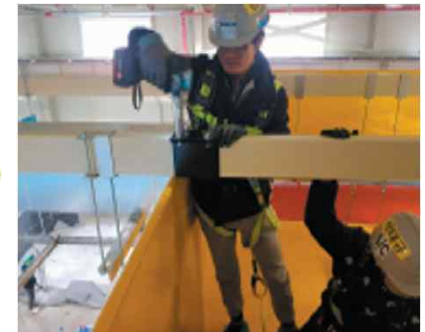
작업 높이 개선 (눈높이 작업)
