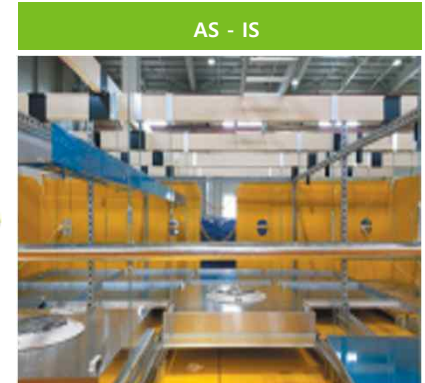
넓은 작업대 위 자재 인양/제작/설치
