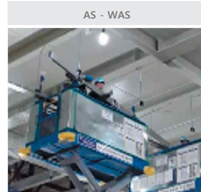
협소한 고소작업대 위 중량 자재 설치
